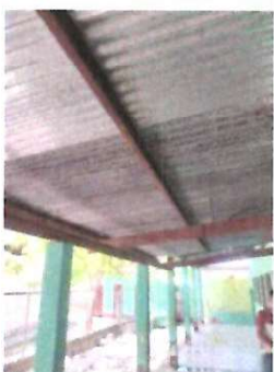
ESTRUCTURA DE TECHO, SUSTITUCION DE ESTRUCTURA EN MAL ESTADO, CUBIERTA DE LAMINA, SUSTITUCION DE LAMINA ONDULADA EN MAL ESTADO POR TROQUELADA
