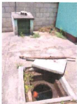
REPARACIÓN Y MANTENIMIENTO DE CISTERNA/DEPÓSITOS DE AGUA REPARACION CISTERNA, TUBERIAS Y ACCESORIOS
