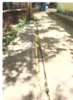
REPARACIÓN DE RED DE DRENAJES Y RED DE AGUA POTABLE Sustitución de tuberías PVC para redes hidráulicas de drenaje, adherencia entre cortes, uniones de tubería y accesorios con pegamento PVC
