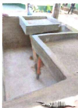
REPARACIÓN O SUSTITUCIÓN DE ÁREA DE COCINA Reparacion pila, nivelada y con conexiones hidráulicas.
